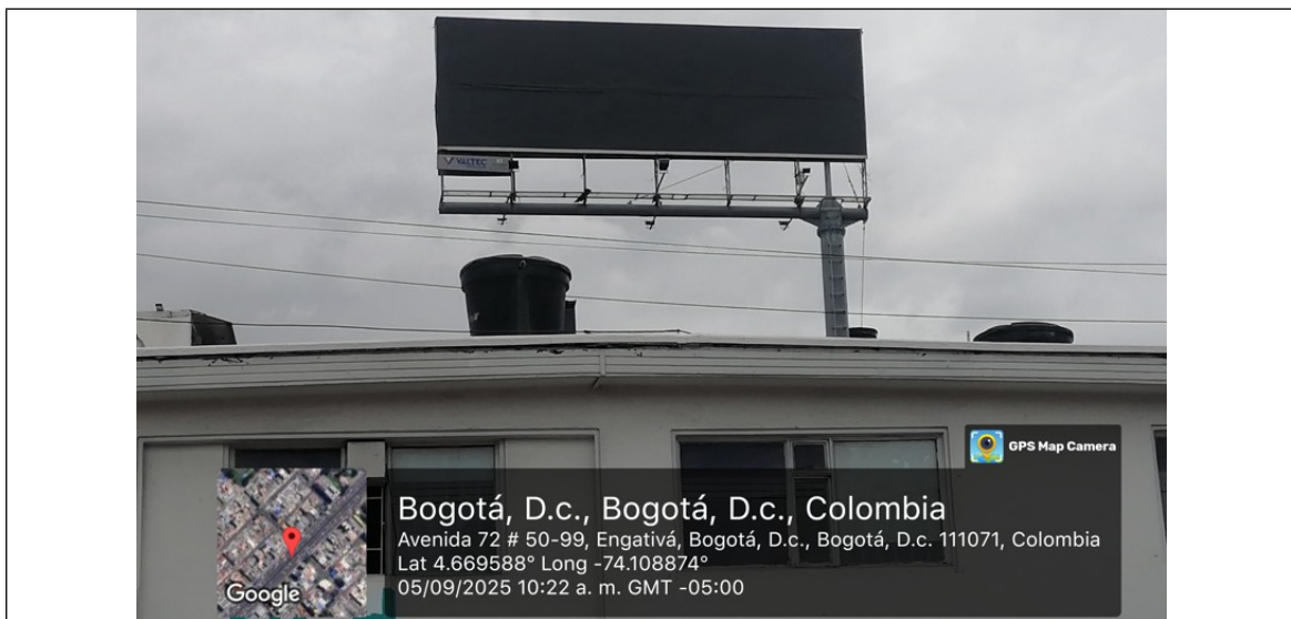
Fotografía No. 2 – Vista de la estructura de la valla, en buenas condiciones y estable.
